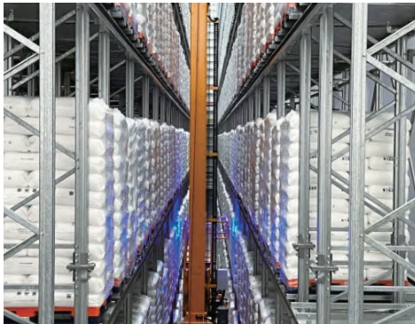
镇海炼化拥有国内首个全自动出入库 3.9 万吨级聚烯烃智能立体库
