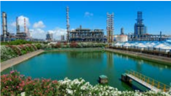
镇海炼化创新应用炼油达标外排污水适度处理回用技术，该技术获 8 项国家发明专利。20 余年来，总计回用炼油达标外排污水量相当于 13 个西湖的容量
